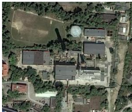
Reprezentarea 54: Centrala Termică CT-Sud, Chișinău
