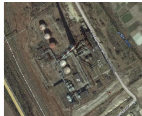
Reprezentarea 55: Centrala Termică CT-Est, Chișinău
